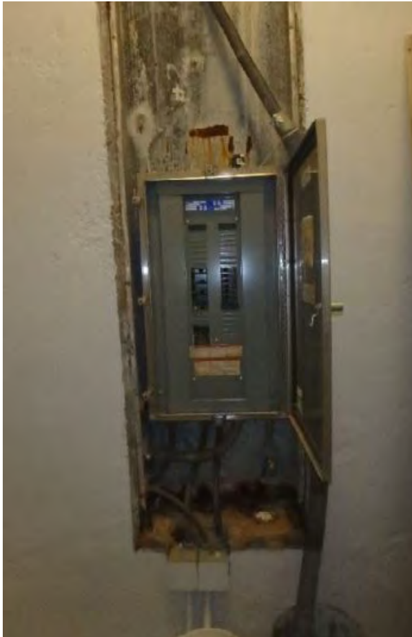
FIGURE 5-10. Conduit drain bucket (QE, 2021).
