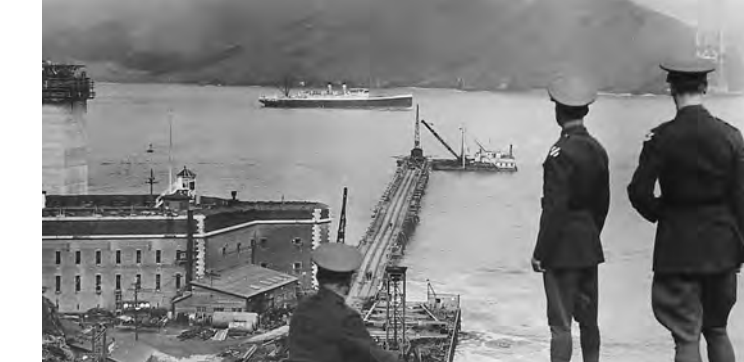
1933年、ゴールデンゲートブリッジ支柱の基礎建築工事。
