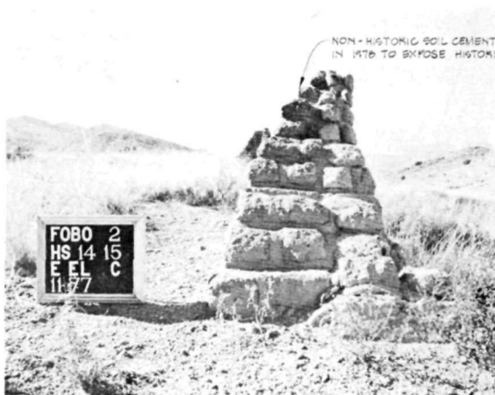
(D) HS 014 * 015 * WALL C * EAST ELEVATION
