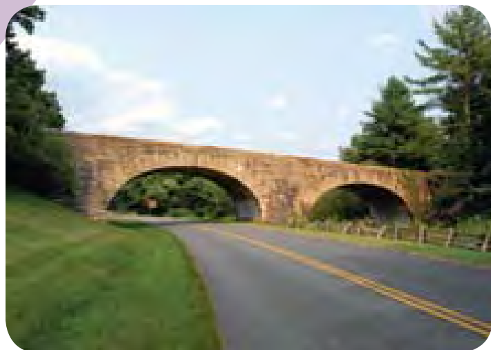
Low Gap Bridge, VA
