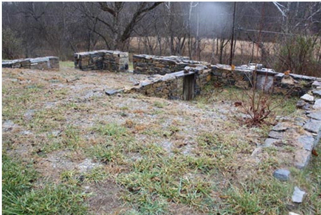
Tenant House foundations
